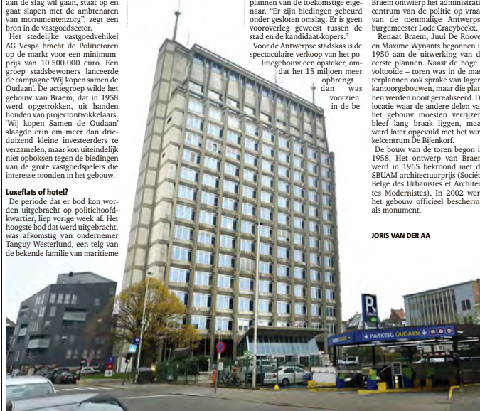
De renovatie van het geklasseerde gebouw op de Oudaan zal volgens bronnen in de vastgoedsector nog heel wat voeten in de aarde hebben: "Wie hiermee aan de slag gaat, staat op en gaat slapen met de ambtenaren van monumentenzorg", klinkt het. FOTO: WIM HENDRIX
